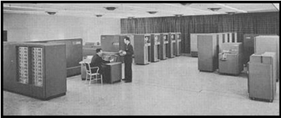
Instalación servidores IBM 705 Año 1955
